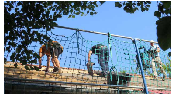
Um auch für die Zukunft gerüstet zu sein wurde u.a. das Dach des Jugendzentrums Saftladen mit einer neuen Dämmung versehen.
