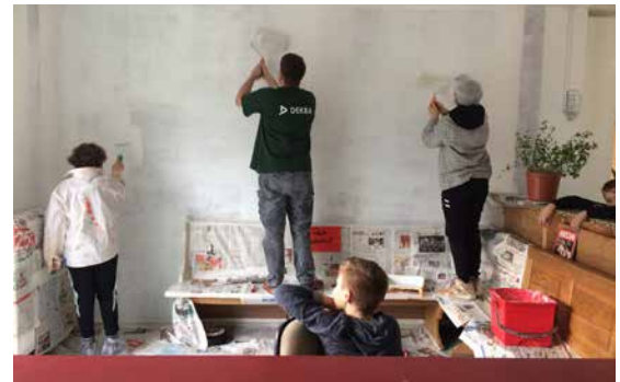
Große Renovierungsarbeiten bei denen auch unsere Besucher_innen fleißig mithalfen.
